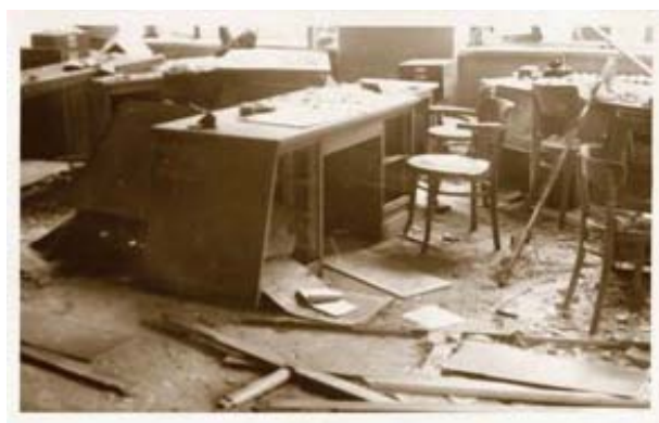
Fotografie zniszczonego budynku przy ul. Francuskiej 12 i jego wnętrzu z początków 1945 roku (ze zbiorów BŚ)
