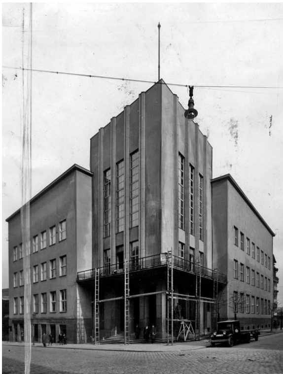
Dom Oświatowy Towarzystwa Czytelni Ludowych w Katowicach w trakcie budowy, 1930–1934
