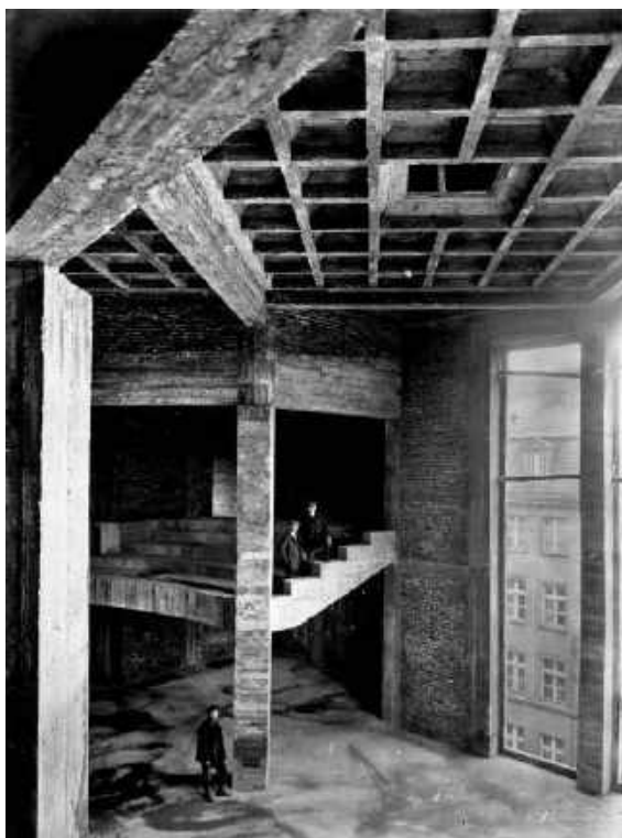
Dom Oświatowy Towarzystwa Czytelni Ludowych w Katowicach w trakcie budowy – sala odczytowa, 1930–1934
