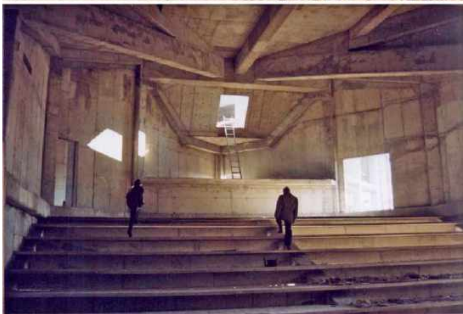
Fotografie z przebiegu prac budowlanych, 1994, fot. J. Jarecki. U góry: widok na korpus główny od strony obecnego parkingu pracowniczego.
