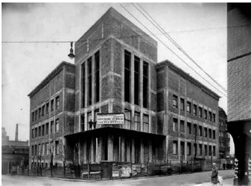
Dom Oświatowy Towarzystwa Czytelni Ludowych w Katowicach w trakcie budowy, 1930–1934
